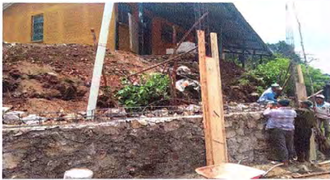
REGLÓN. REPARACIÓN DE MURO DE CONTENCIÓN.
