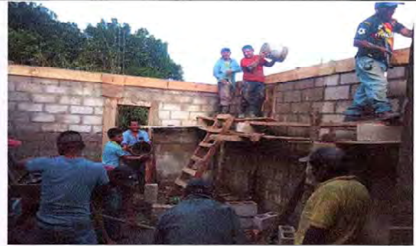
REGLÓN 2. REPARACIÓN DE COCINA DE LA ESCUELA.
