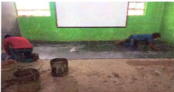
REGLÓN 5. COLOCACIÓN DE PISO CERÁMICO.
