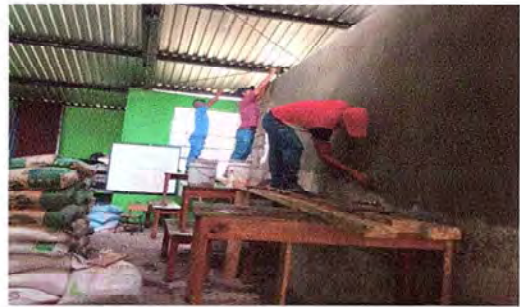
REGLÓN 4. REPELLO DE AULAS Y COCINA.
