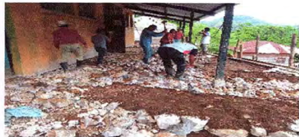
REGLÓN 6. SUSTITUCIÓN DE PISO CONCRETO FRENTE LA ESCUELA.
