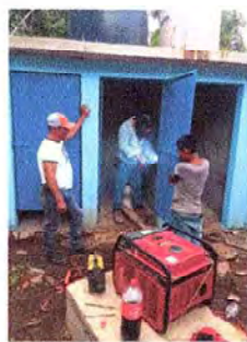
REGLÓN 3. COLOCACIÓN DE INODOROS Y PUERTAS DE SERVICIOS SANITARIOS.
